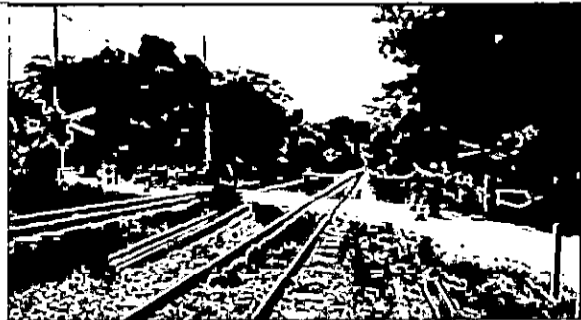
FOTO 16. PASO A NIVEL EN EL CORREGIMIENTO DE RIO FRIO
