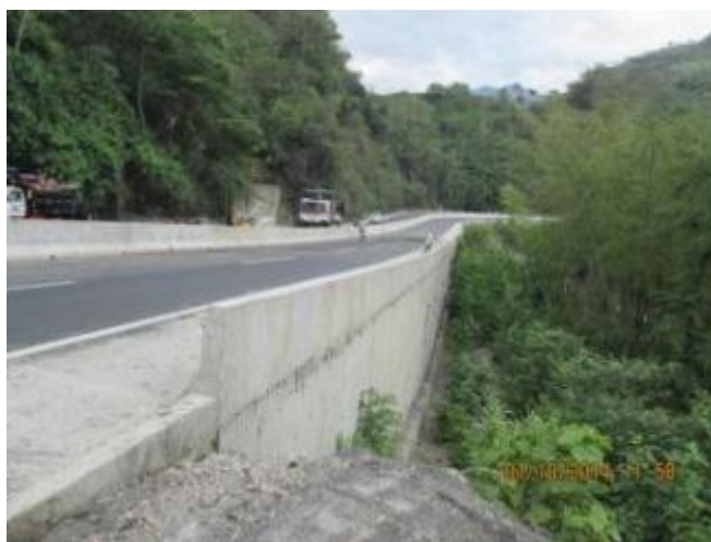
FOTOGRAFIA 1: Vía doble calzada ampliada y reconstruida del Km 67+000 al Km 67+180, a nivel de capas asfálticas, con separador tipo New Jersey, se construyen cunetas faltantes al costado norte; se requirió construir estructuras en concreto reforzado para soporte de la calzada sur. Tramo 2.
