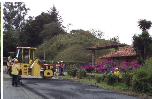
Compactación de asfalto PR 93+800
