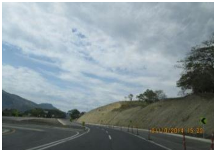
FOTOGRAFIA 2: Se observa el retorno vehicular bidireccional construido en el Km 75+200, además de la vía doble calzada en operación vehicular. Tramo 2.
