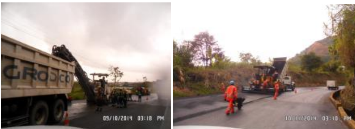
Foto: Actividades de fresado e instalación carpeta asfáltica en la Variante Troncal de Occidente Tramo Belmonte-Mandarino.
