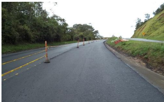
Intalacion de asfalto PR 88+400
