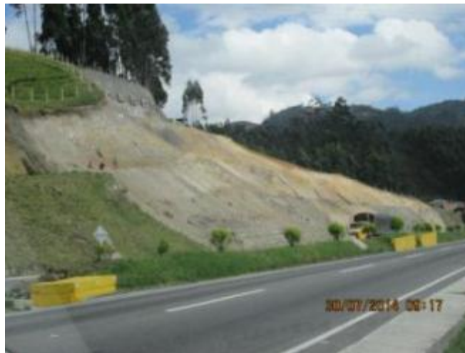
FOTOGRAFIA 6: Obras ejecutadas para estabilizar el talud del costado sur del Km 29+500 al Km 29+670, se conformaron terrazas, se protegió el talud superior con concreto y anclajes. Tramo 5.
