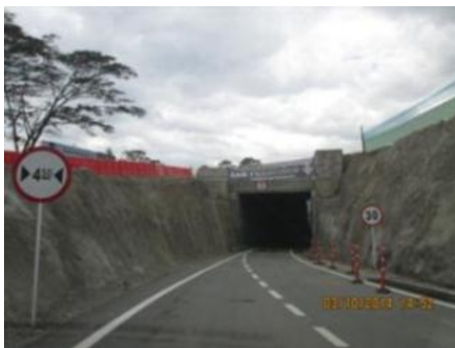
FOTOGRAFIA 4: Km 47+700, Portal de ingreso a la estructura tipo deprimido construida para el acceso hacia el municipio de San Francisco, por la vereda de Minas. Tramo 3.
