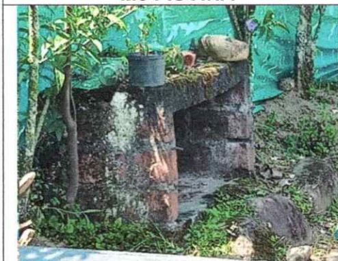
M10 CAJA DE REGISTRO
