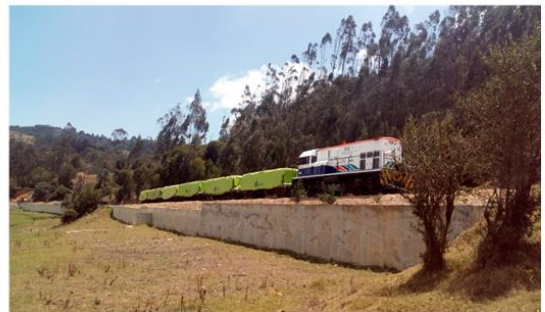
Foto Tren de Prueba Corredor Bogotá - Belencito
