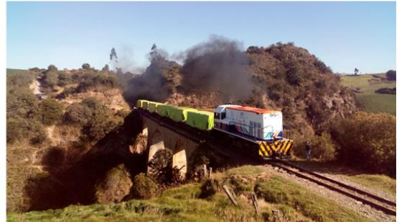
Foto Tren de Prueba Corredor Bogotá - Belencito
