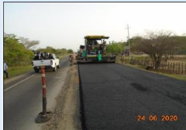
Mantenimiento estructura de pavimento sector 90-09
