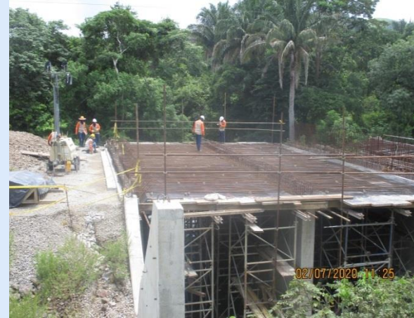
Tramo 8 Hito 27B VN CI BOX COULVERT K28+169 Armado de acero para placa superior
