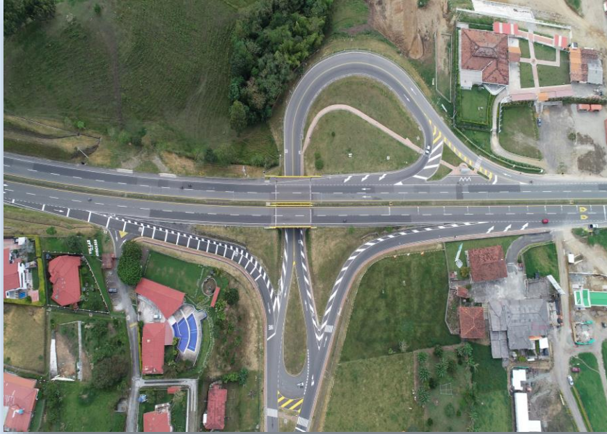
Tramos Armenia – Pereira Intersección Circasia 1 1/2
