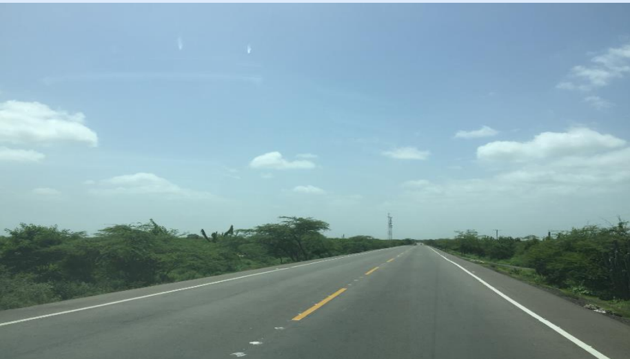
Sector Cuatro Vías – Tramo 3
