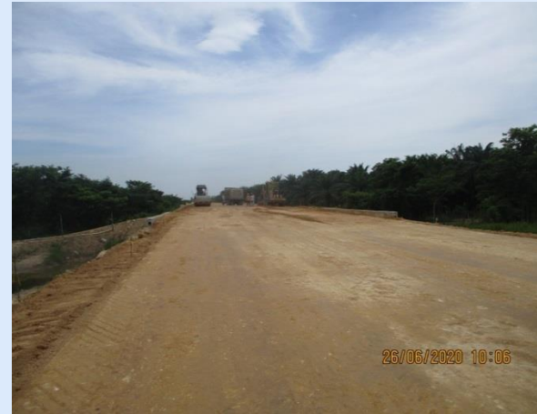
Tramo 1 Hito 3B VN CD K25+700 al K26+000 Conformación de corona de terraplén
