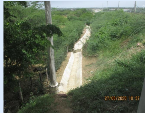
Tramo 7 Hito 36B VN CD K02+790 al K02+860 Construcción de cunetas de coronación
