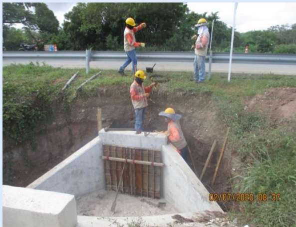
Tramo 7 Hito 34A VN CD Alcantarilla K37+885 Ampliación cabezal y aletas
