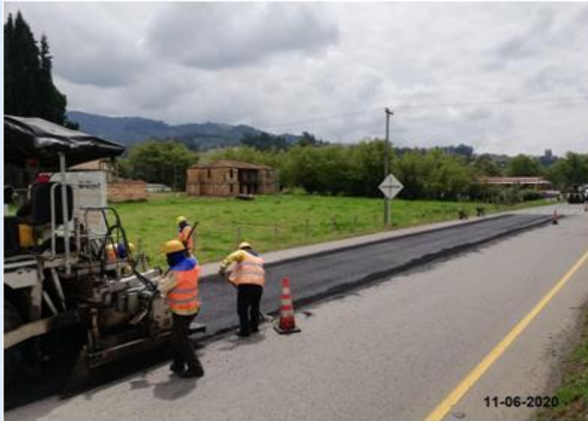
Mantenimientos carpeta asfáltica PR33+800 Ruta 5502 Trayecto 14
