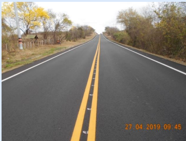
Ruta 8801 Maicao – Paradero con labores de mantenimiento periódico culminadas
