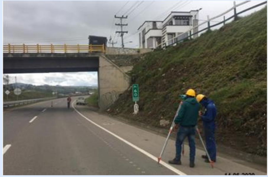
Nivelación Pistas para medición de IRI PR60+000 Ruta 5501 Trayecto 6
