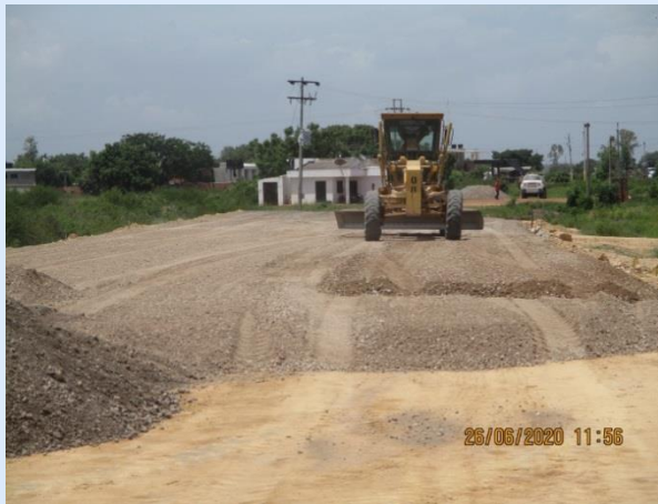
Tramo 2 Hito 5A VN CD K00+450 al K00+700 Conformación de Subbase granular
