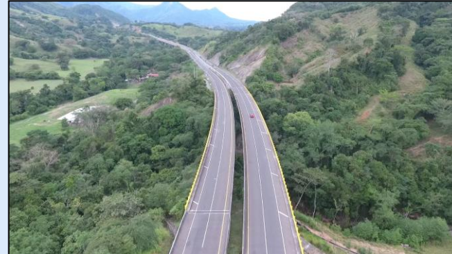
PR 14+150 AL PR 14+900 Tramo 2
