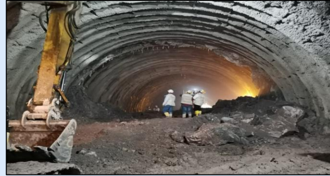
Cale del túnel 8 Tramo 1
