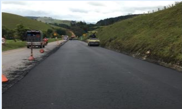
Actividades de instalación de mezcla asfáltica para sobre carpeta. PR51+450 al PR51+552
