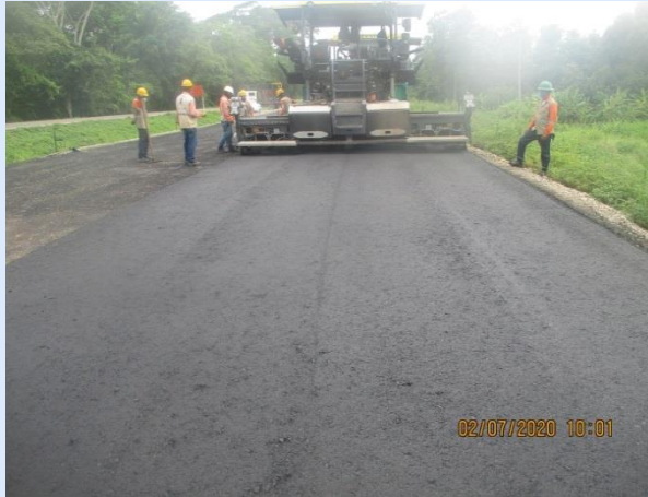
Tramo 1 Hito 1B VN CD K03+621 al K 03+700 Mezcla asfáltica MDC-25 Carril derecho
