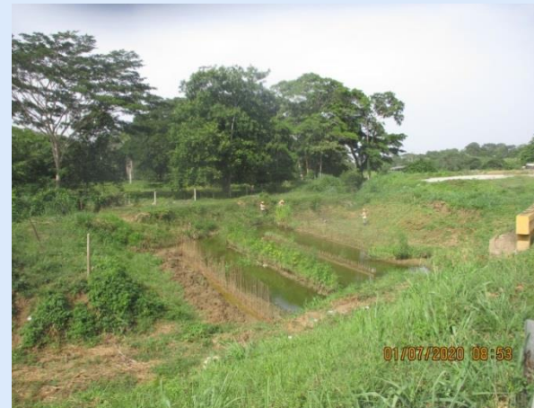
Tramo 6 Hito 38D VN CD BOX COULVERT K67+330 limpieza para reinicio de obras
