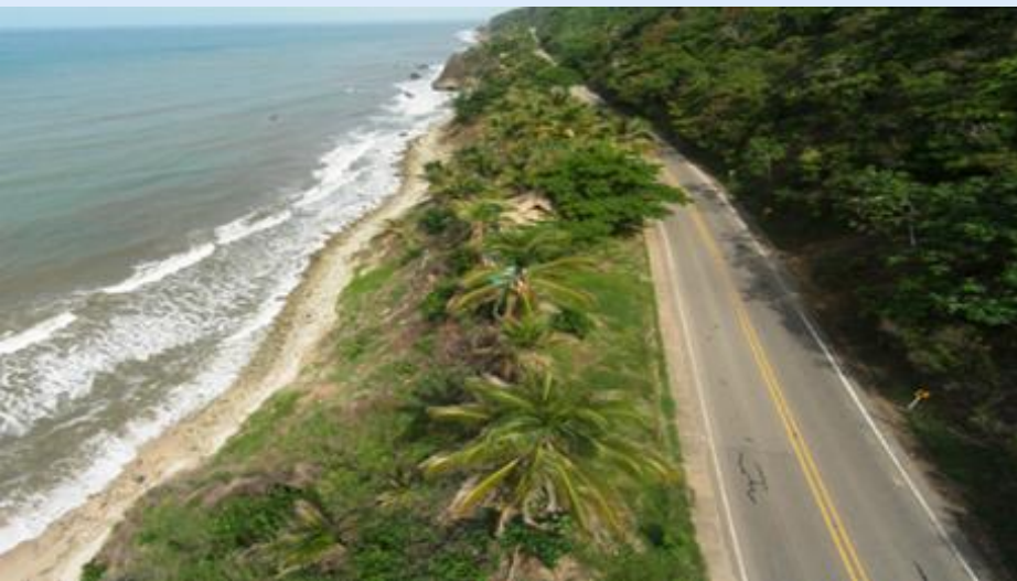
Obras de protección marina sector Los Muchachitos - Tramo 1
