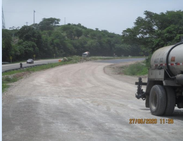
Tramo 8 Hito 25 VN CD K00+990 al K01+340 Imprimación de base granular
