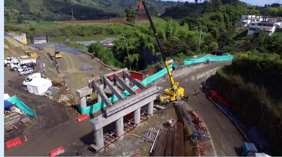
Intersección a desnivel el Jazmín
