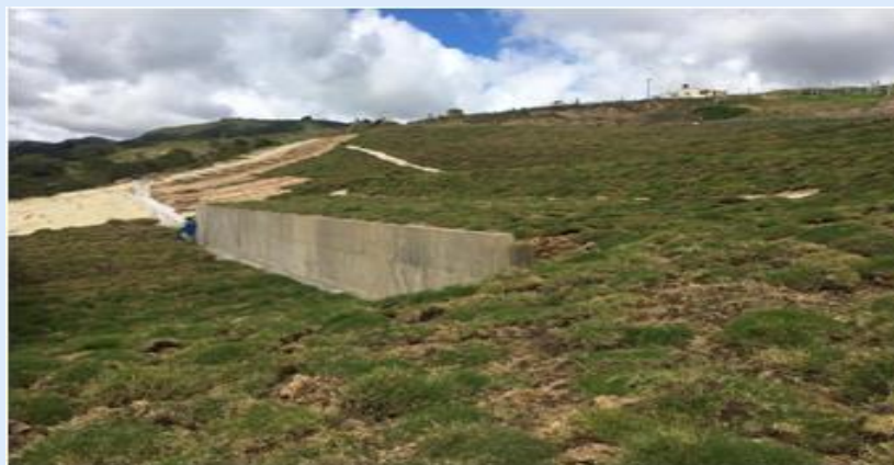
Construcción de muro de contención soportado cimentación profunda tipo caisson PR69+275
