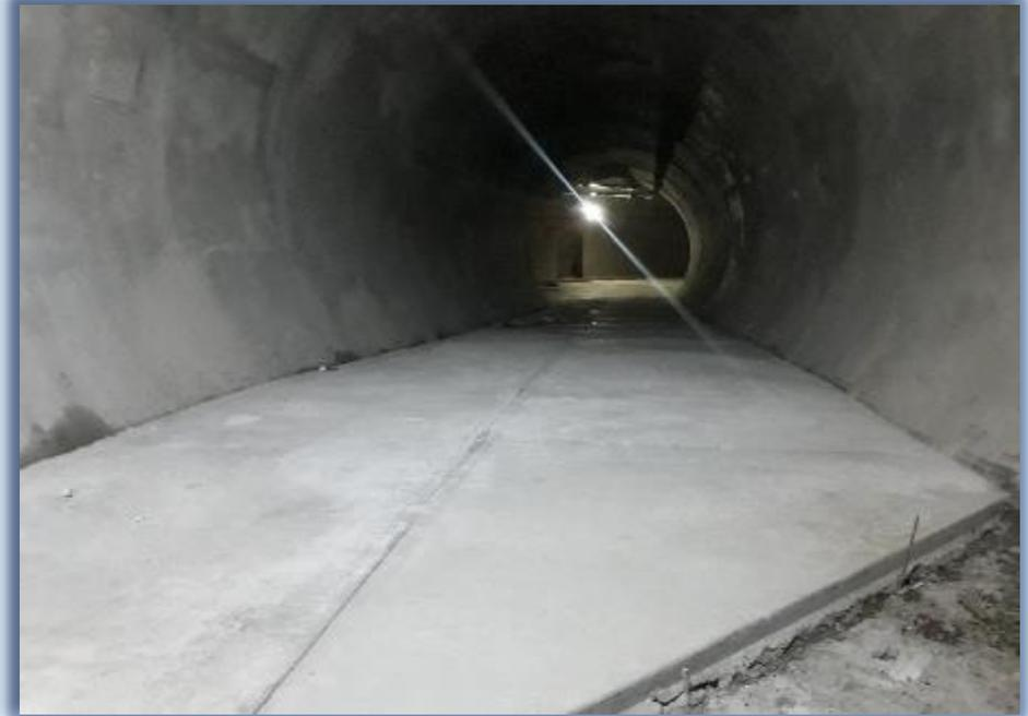
Foto No.4 UF3. Hormigonado piso de galerías de conexión #1, #3 y #5.
