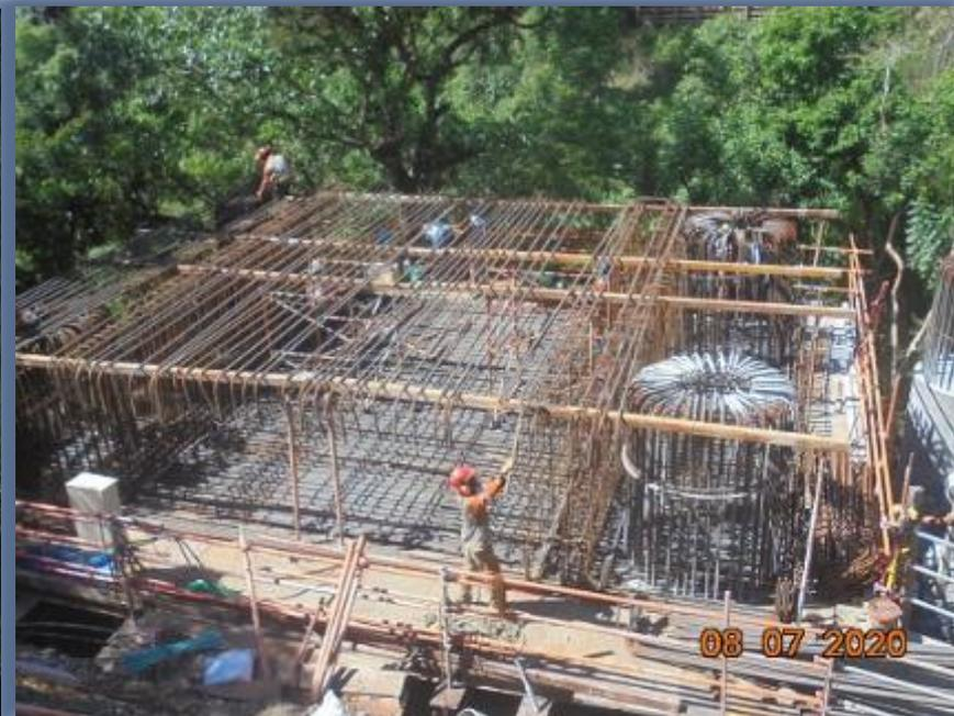
Foto No.2 UF4. Km 38+817, Construcción de zapata, Puente Marvalles, apoyo 2, CI.
