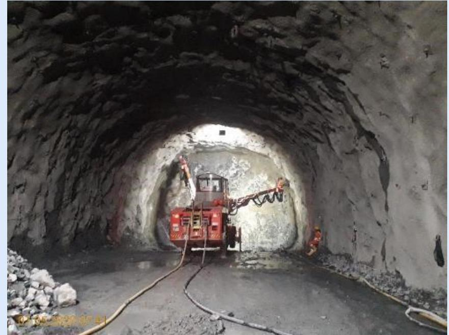
Perforación para cargue de explosivos y excavación por medio de voladura en la calzada derecho. Portal Salida de Amagá, UF3.
