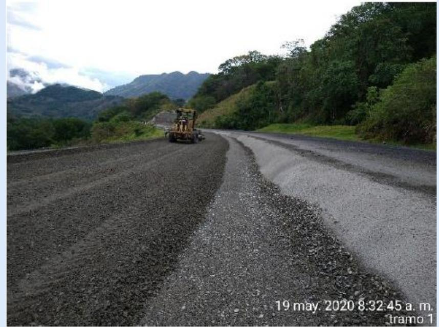
Descargue, extendido, compactación y céreo de base granular en el K0+250, tramo 1. Calzada izquierda.
