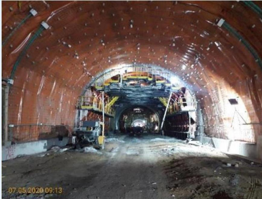
Vaciado de concreto para revestimiento en el módulo 26 del tubo Izquierdo. Túnel Sinifaná.
