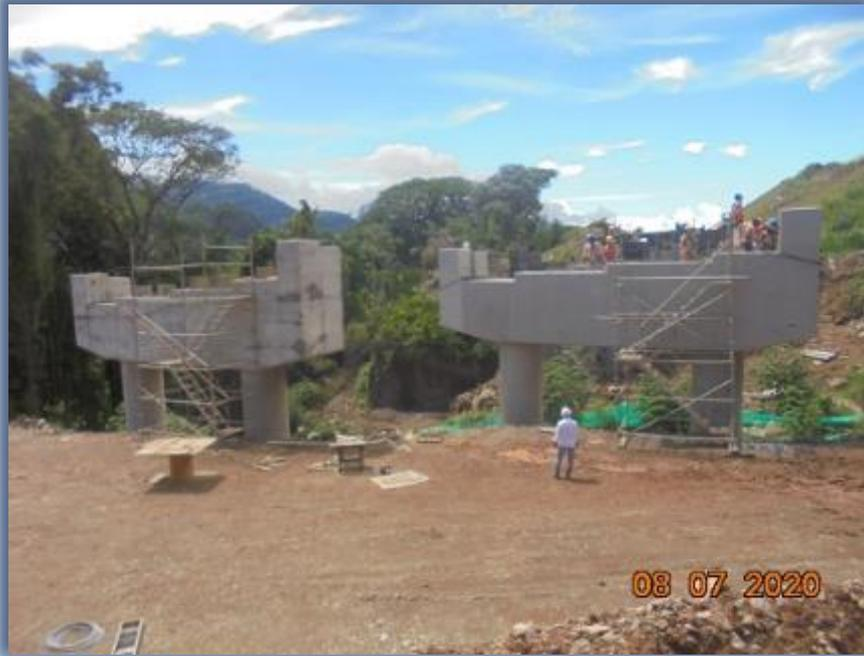
Foto No.3 UF2. Km 27+560, Subestructura terminada, apoyo 3, Puente La Batea.
