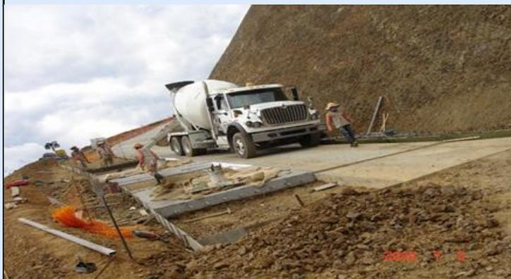
PK 9+200 Construcción del pavimento rígido para el uso de la comunidad de Mestizal alto. Se trabaja fundiendo placa en el carril derecho "bajando". Se utiliza concreto pre mezclado con MR de 4.2 MPa
