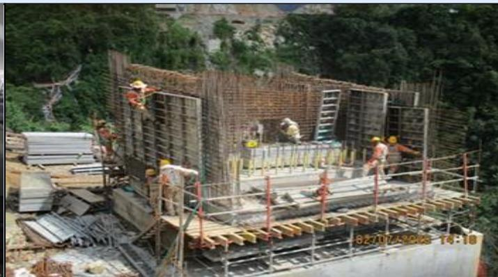
Puente PK 6+240 UF 1- PILA 2. Instalación de acero de refuerzo muros Dovela sobre Pila y Dovelas N°1
