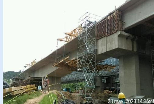
UF 7. RUTA 6512 – PR 91+046 PUENTE CHARTE CALZADA DERECHA. Construcción de Voladizos sucesivos, Vaciado dovela sobre pila, voladizos 2 y 3 Pila 1.
