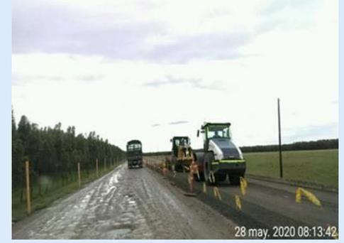
UF4. RUTA 6511 - K16+480-K17+100 - Continúan con la conformación y compactación de material sub-base granular, ampliación de la vía margen derecha.
