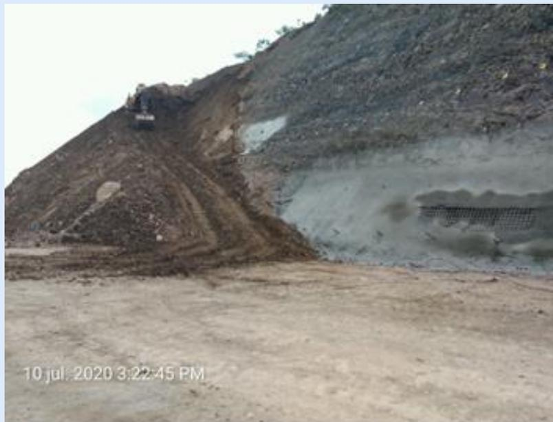
**UF 7.** Excavación mecánica para corte vertical de talud K98+250.
