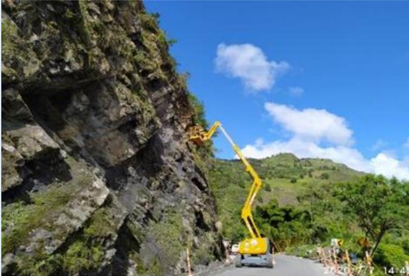
Instalación pernos de anclaje sobre talud PR 19+011
