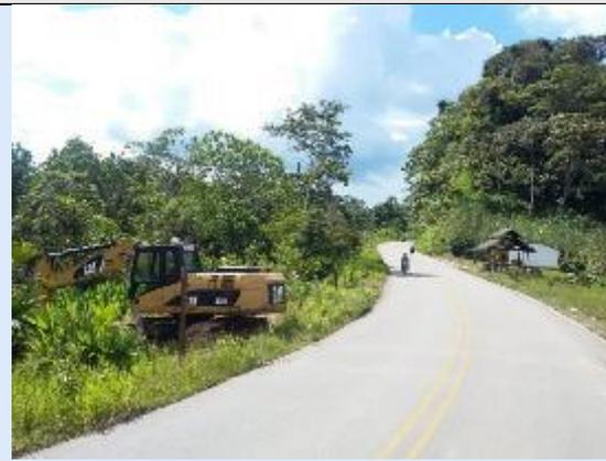
Canalización PR 32+0100 tramo 4502. Ampliación de la banca y renovación carril derecho con asfaltita.
