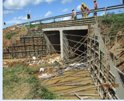
UF3. PR67+630 trabajo de vaciado de concreto en aletas de box culvert al margen izquierdo.
