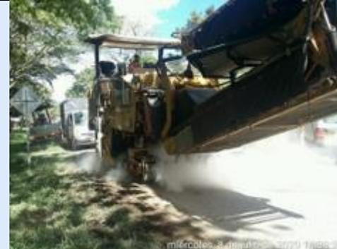
FRESADORA REALIZANDO LABORES DE LEVANTAMIENTO DE CARPETA ASFALTICA.
