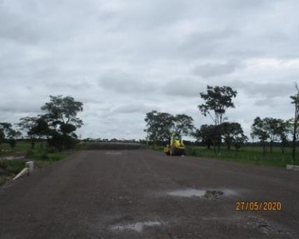
UF1 Variante Cumaral Trabajo de instalación, y compactación de material para la construcción de terraplén
