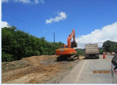
UF 2. PR49+550 al PR50+000 Trabajos de corte de talud, excavación y conformación en el sector de La Guala.
