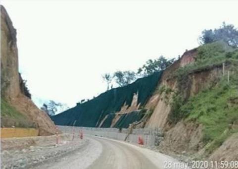
UF 6. RUTA 6512 - K57+000 - K57+300 - Continúan con las actividades de corte de talud, ampliación de la vía, margen izquierda.
