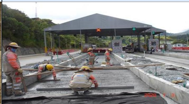
PK 0+060 Playa de peajes. Se realiza actividad de demolición de placas de pavimento rígido fracturadas. En su fundida, se les instala doble panel de malla electrosoldada de acero y se utiliza concreto premezclado de 4.2 MPa.
