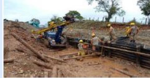
SITIO CRITICO 4+00 RN4502 – EXCAVACION Y FUNDICION EN CONCRETO 3.000 PSI PARA MICROPILORES
