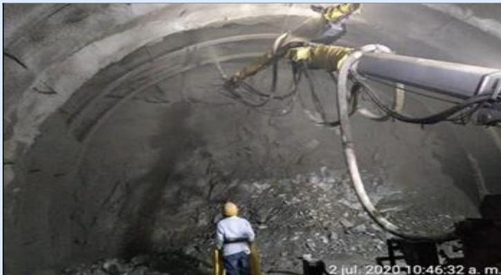
PK3+138,5 - UF3.1B - Instalación de concreto lanzado 30 MPa, excavación túnel principal, sección sostenimiento tipo SC-4R. Portal Santa Fé.
