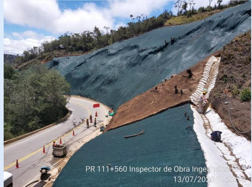
**UF4. Mutiscua – Pamplona: Sector PR 111+560 Estabilización de talud con hidrosiembra.**
