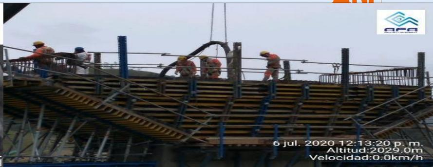
Vaciado viga cabeza Pila 4 Viaducto No. 205 - PK 53+719 / PK 53+923
