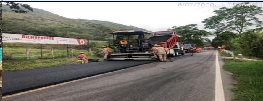
Instalación mezcla asfáltica MSC-19, carpeta de rodadura PR92+900 - PR94+550 carril derecho - sentido PACU
