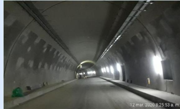
UF 3: Túnel 5 frente 2, apariencia interior túnel, avanza la instalación de bandejas porta cables.
