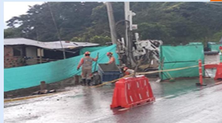
Ejecución de cimentación por micropilotes, sentido Girardot – Bogotá, PR84+300
