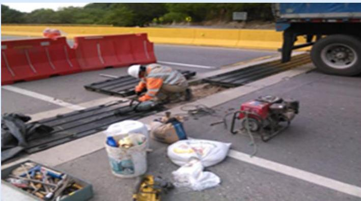
Se realizó la actividad de reparación de juntas de dilatación puente vehicular. sentido Girardot – Boootá. PR9+300
