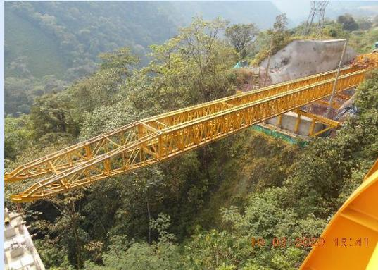
UF 5: : En el puente 9, Continúan el armado y las adecuaciones de la estructura de la viga cimbra.
