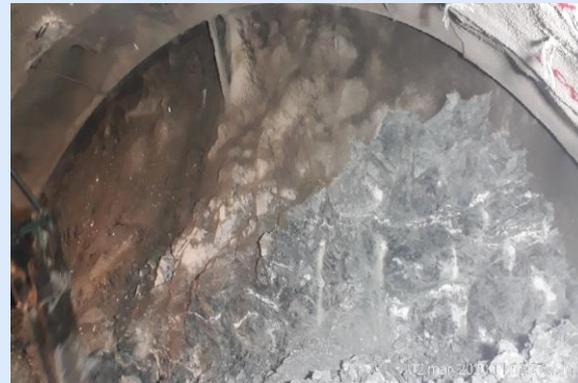
UF6: Túnel 7 frente Villavicencio, continua el terreno tipo V, soporte ST 3.1, pases a 1.5 m.
