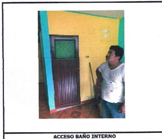
ACCESO BAÑO INTERNO
