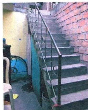
ESCALERAS EXTERNAS EN CONCRETO
