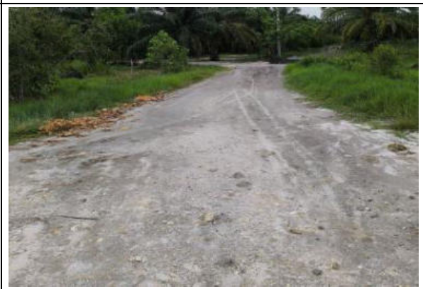
CA6. Adecuación Terreno
