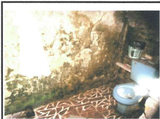
CONSTRUCCION C2 BAÑO
