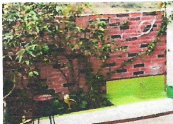
MURO 3 EN LADRILLO
