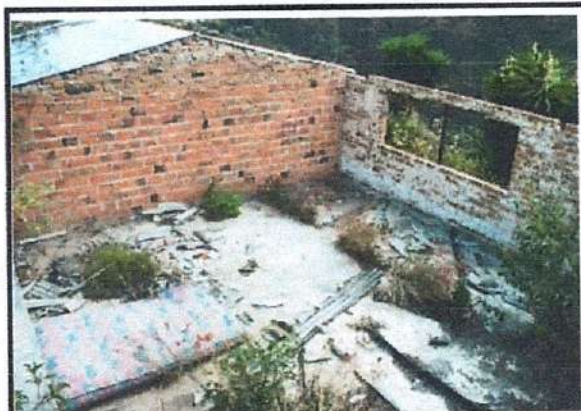
CONSTRUCCIÓN EN RUINAS
