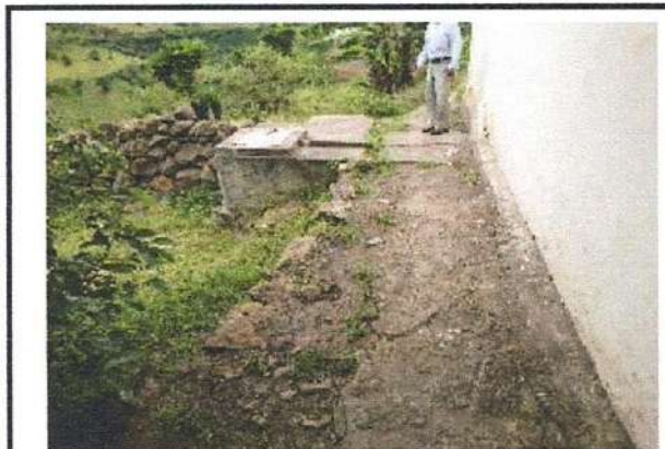
CAJA EN CONCRETO
