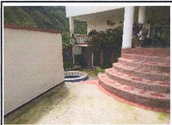
ZONA DURA CONSTRUCCION 1, ESCALERAS ACCESO
