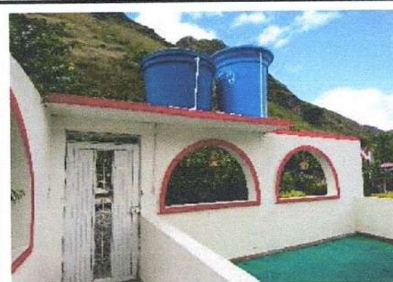
TERRAZA, SOPORTE TANQUE
