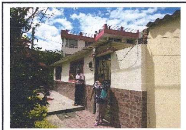
ACCESO A CONSTRUCCION
