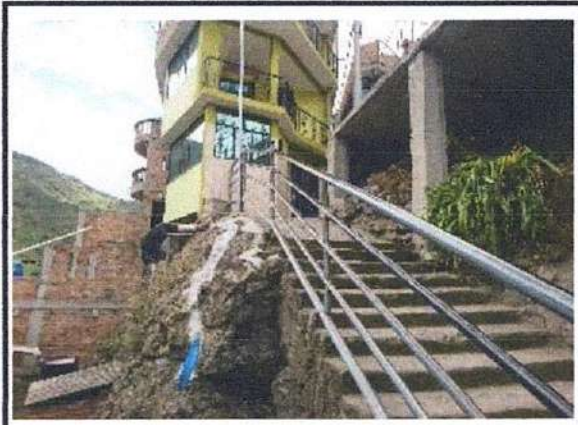
ESCALERA DE ACCESO AL PREDIO (PASAMANOS METALICO)
