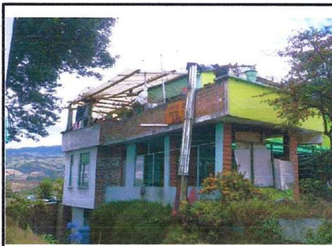
FACHADA LATERAL CONSTRUCCION 1
