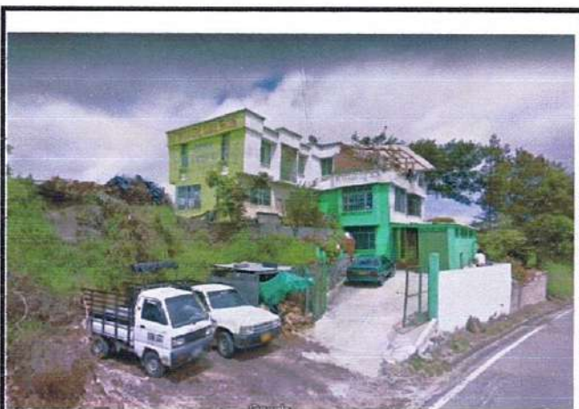
FACHADA POSTERIOR - MUROS
