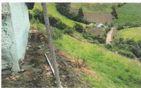
A1 EXCAVACION VIVIENDA
