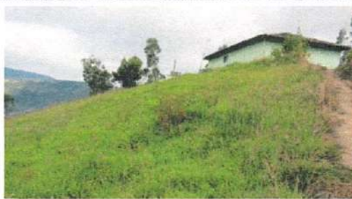
A7 POZO SEPTICO (LOCALIZACION)
