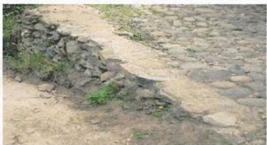
A6 MURO EN PIEDRA
