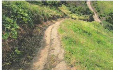
A2 EXCAVACION CAMINO
