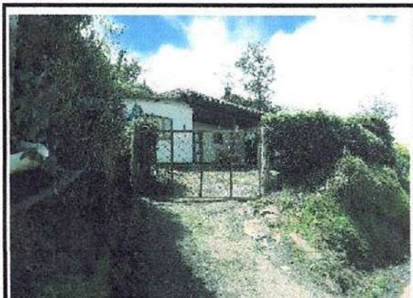
ENTRADA AL PREDIO
