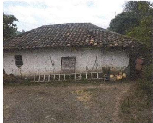
CONSTRUCCION PRINCIPAL 1-VISTA LATERAL
