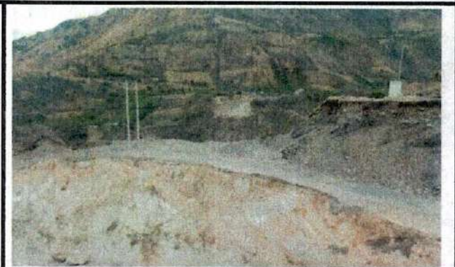
VISTA DEL SECTOR
