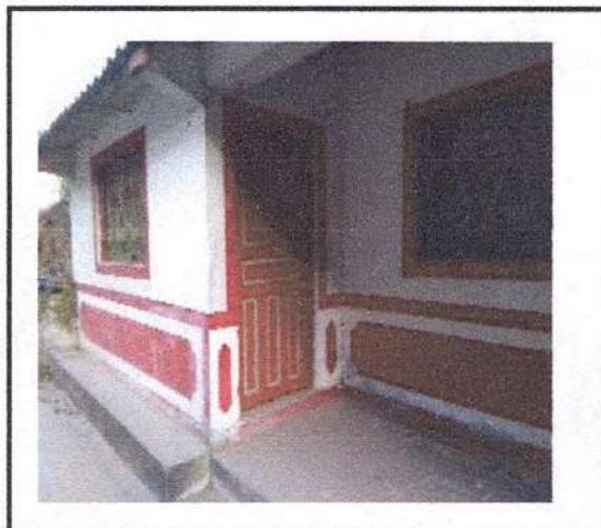
FACHADA DE LA VIVIENDA
