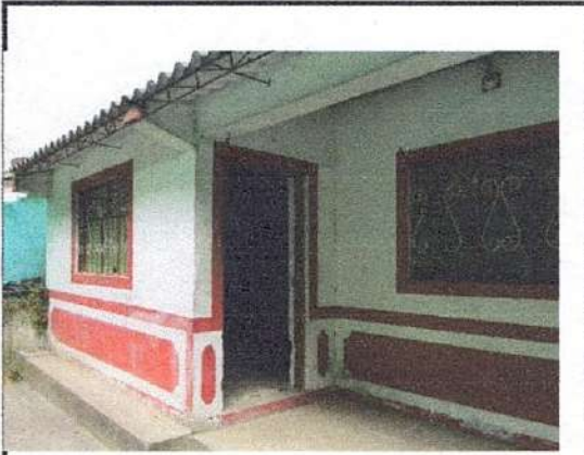
ASPECTO GENERAL CONSTRUCCION 1
