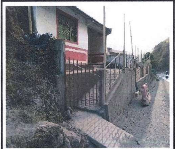
FACHADA DE LA VIVIENDA Y MURO 3
