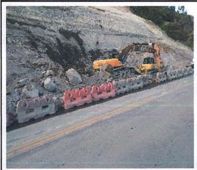
VISTA GENERAL DEL SECTOR
