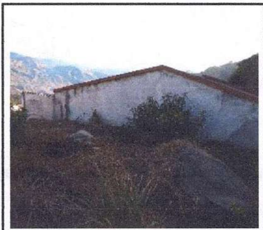
VISTA LATERAL DE LA CONSTRUCCON
