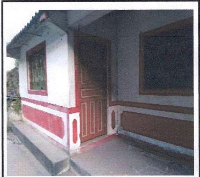
FACHADA DE LA VIVIENDA
