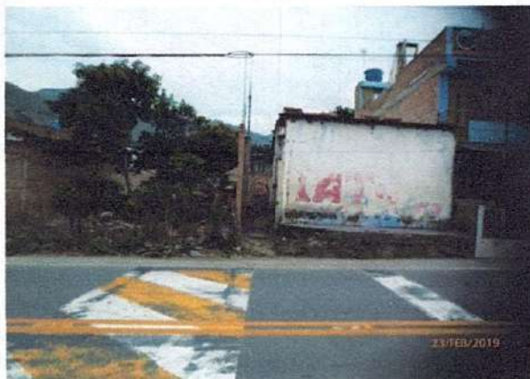
ENTRADA (ACCESO) AL PREDIO
