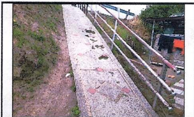
CONSTRUCCIONES ANEXAS 2 - RAMPA CON PASAMANOS
