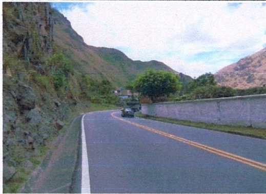
PANORAMICA DEL SECTOR PEDREGAL - TANGUA
