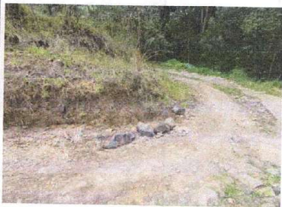
CAMINO DE ACCESO EN RECEBO
