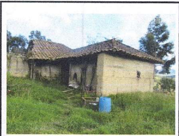
FACHADA CASA DE HABITACION
