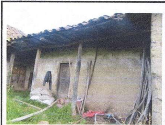
VISTA DE LA CONSTRUCCION 1
