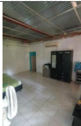
C7. Vista Construcción Interna
