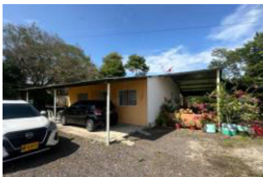
C1. Vista Construcción 1
