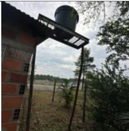
CA17. Estructura para Tanque
