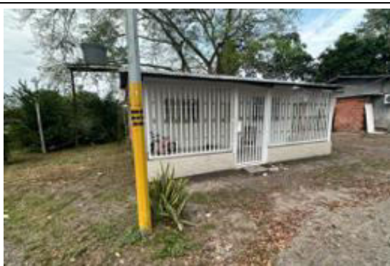
C3. Vista Construcción 3
