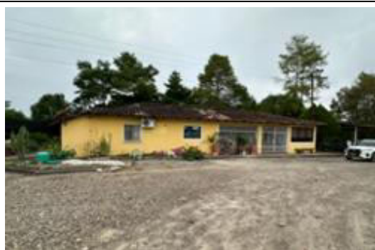
C2. Vista Construcción 2
