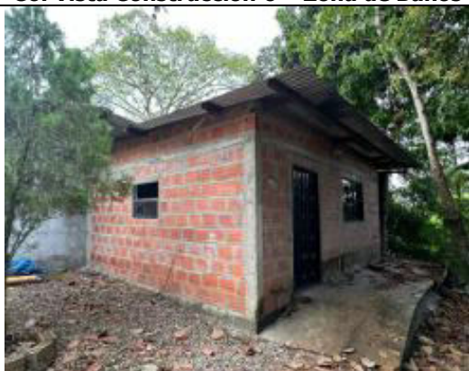
C7. Vista Construcción 7
