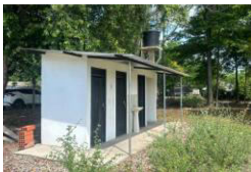
C6. Vista Construcción 6 – Zona de Baños
