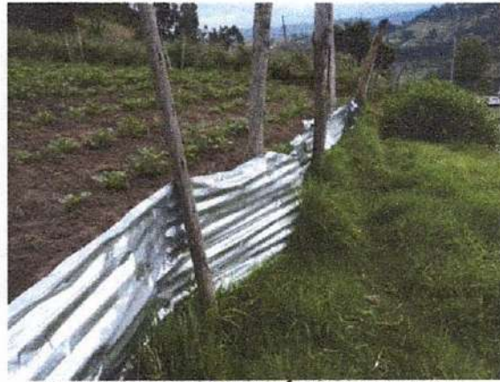
CERRAMIENTO EN LÁMINA DE ZINC
