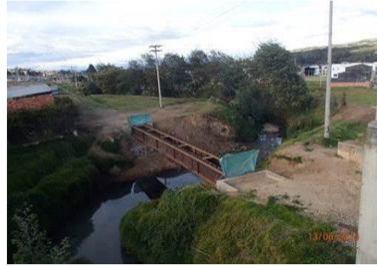
Punto crítico No. 55 PK 184+965
