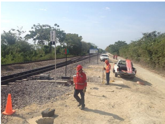
Trabajos de instalación automatización cambiavías
