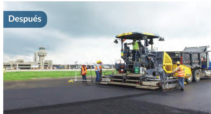
calles de rodaje, los márgenes, la nivelación de las franjas de seguridad, la demarcación horizontal y vertical, y el balizamiento; además se adquirió un nuevo sistema ALS y luces de aproximación.
