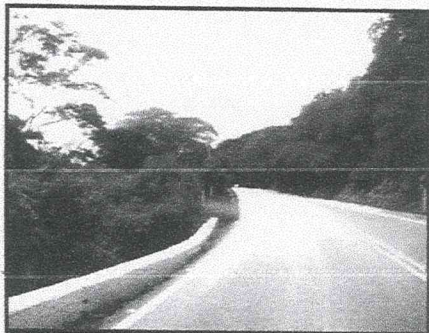
INICIO DE PREDIO RESPECTO A LA VIA
